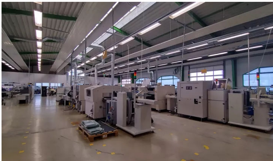
Die 2.000 qm Produktionsfläche werden mit einem neuen ESD-Boden ausgerüstet. (Bild: Heyfra)
